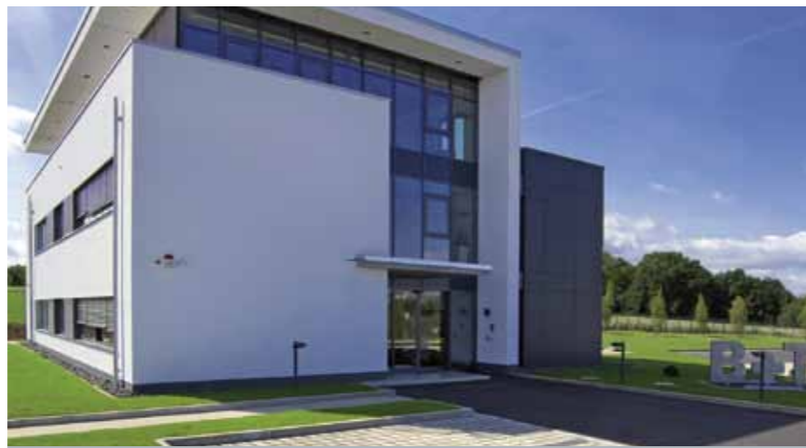
Unternehmensgebäude B+T in Alsfield
